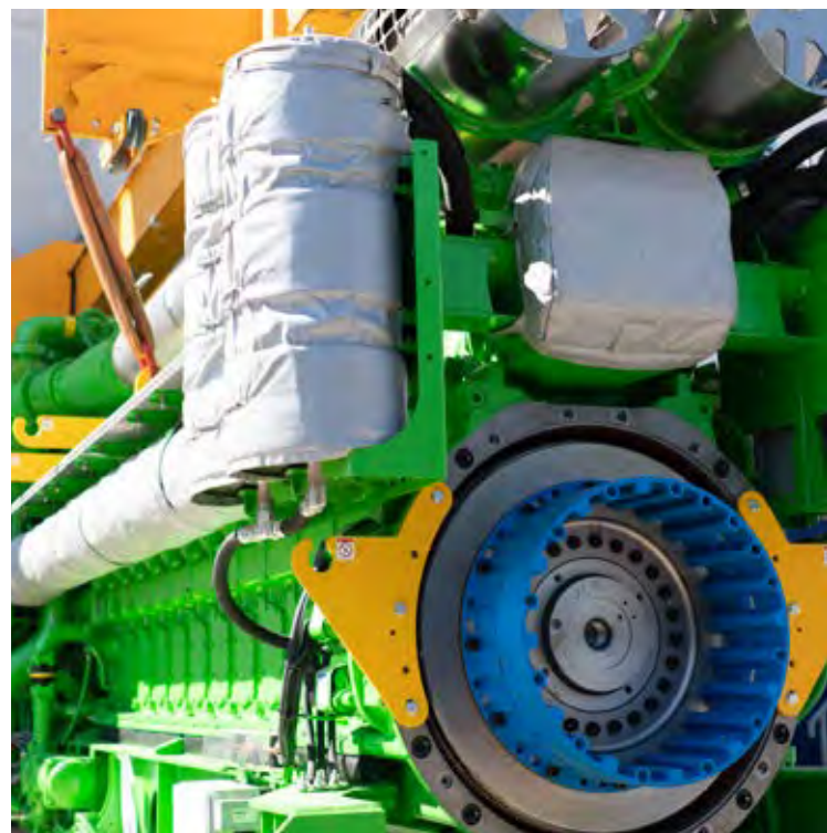
Lieferung und Einbau des neuen Gasmotors für die iKWK2-Anlage in der Oberaustraße
