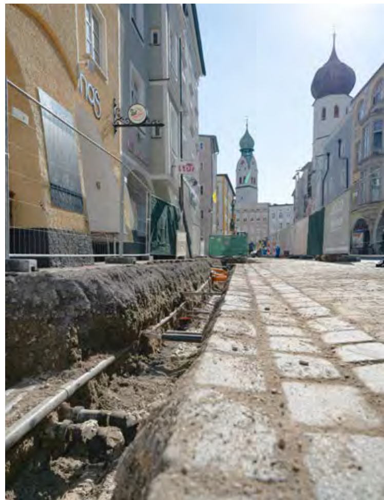
Ausbau Versorgungsleitungen in der Heilig-Geist-Straße
