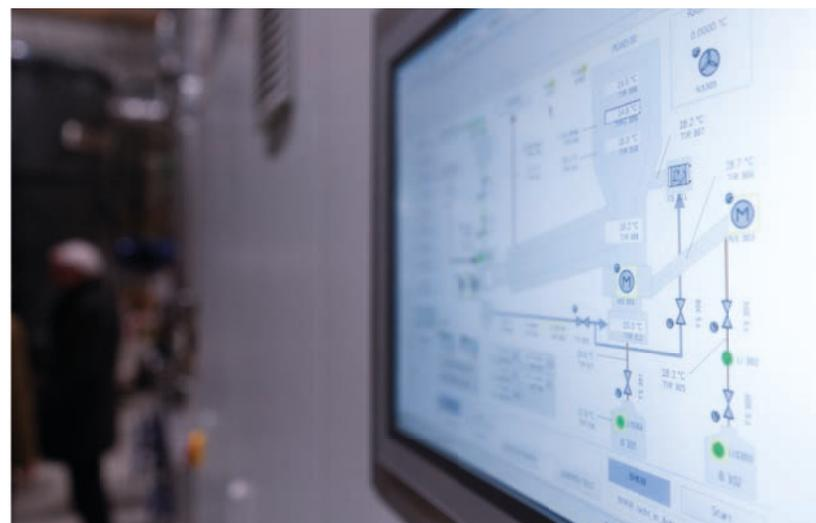
Besonders innovativ ist die bei den Stadtwerken entwickelte Lambda-Regelung des Vergasungsprozesses. Diese Regelung sorgt für eine schnelle, gezielte Modulierbarkeit der Leistung. So unterstützt die neue Holzgasanlage nicht nur die Fernwärme- und Stromversorgung in Rosenheim. Sie trägt sogar zur Stabilität des deutschen Stromnetzes bei, gerade dann, wenn zu wenig erneuerbar erzeugter Strom aus Windkraft- und Photovoltaikanlagen zur Verfügung steht.
