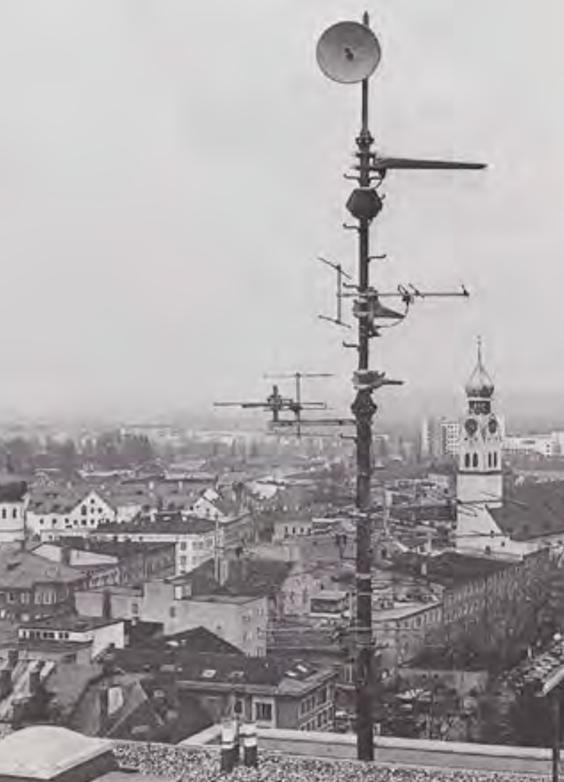
Die „Stadtantenne Rosenheim“ Ende der 70er Jahre auf dem Dach des Sparkassen-Hochhauses
