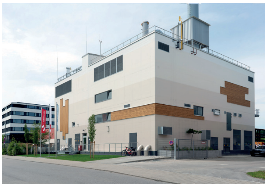
Gebäude der iKWK-Anlage in der Oberaustraße
