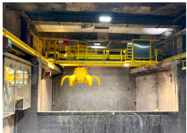
Bild oben: Vorbereitung des Krans aus Nordbayern zur Montage. Bild Mitte: Die Anlage wird durch das Dach des MHKW gehievt. Bild unten: Die neue Hauptkrananlage ist einsatzbereit.
