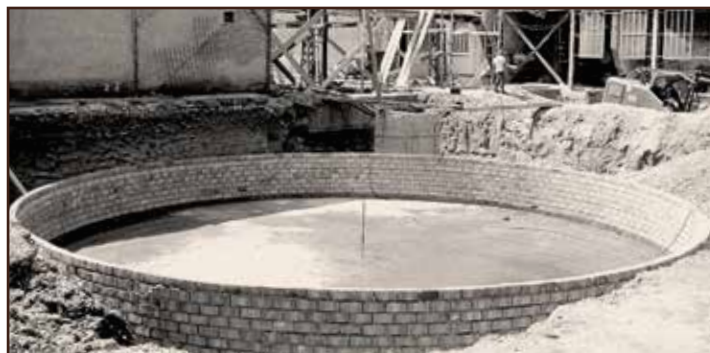
Das Fundament des 80 Meter hohen Kamins.
