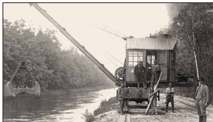
Arbeiter bei der Erhöhung / Tieferlegung des Oberwassers / Unterwassers.
