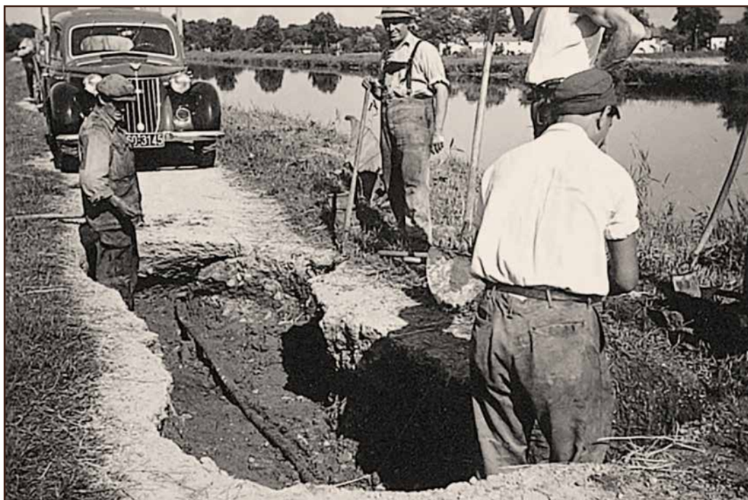
Arbeiter während der Verlegung des 5 kV Verbindungskabels am Mangfalldamm.
