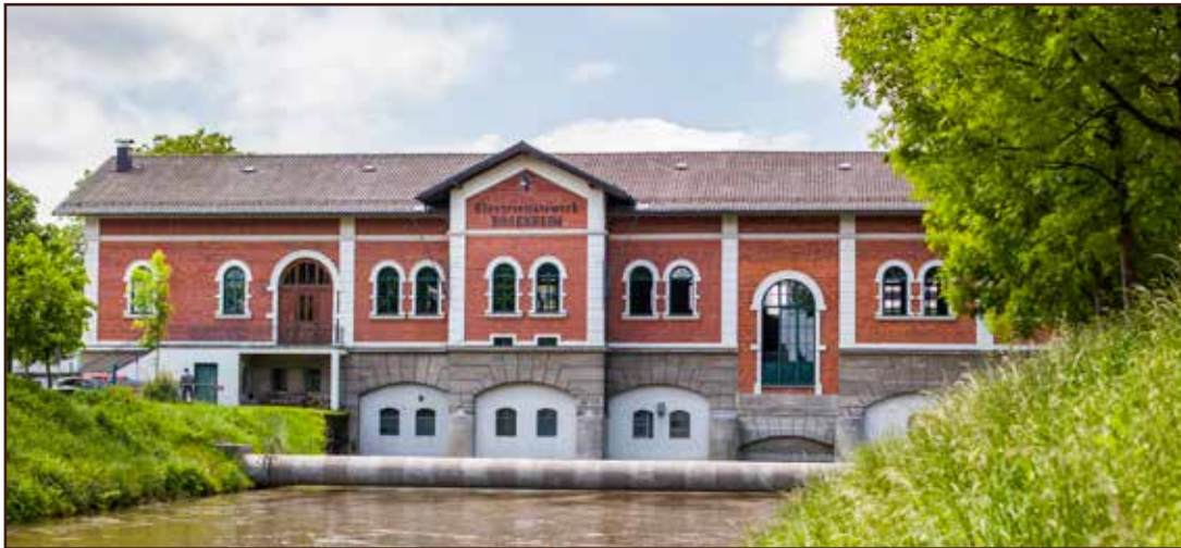
Frischer Außenanstrich für das historische Gebäude.
