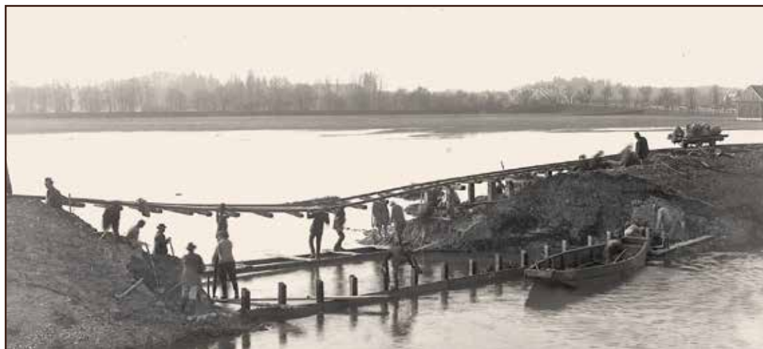
Nach vorherigem Hochwasser in Rosenheim, Dammbbruch am Elektrizitätswerk am Freitag, den 19.11.1920.
