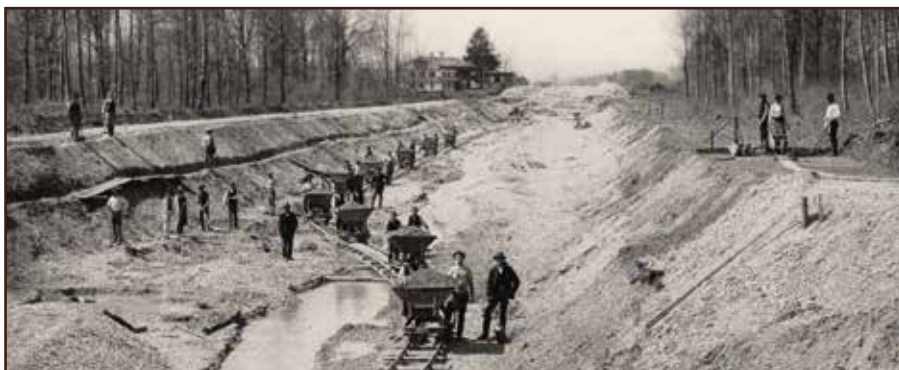
Bauarbeiten am Werkkanal ab Mitterwöhr
