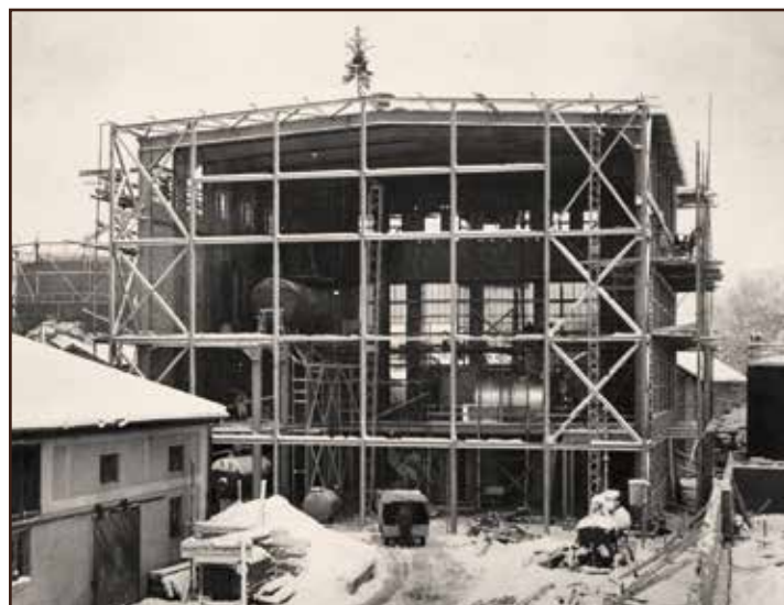
Bau des Heizkraftwerks.
