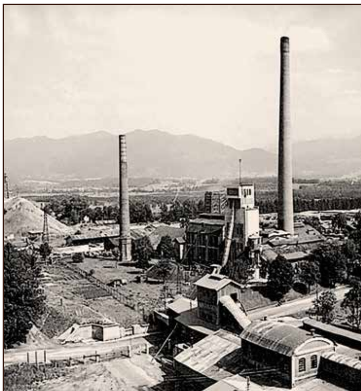
Ansicht des Müllheizkraftwerks mit dem fertiggestellten Kamin.
