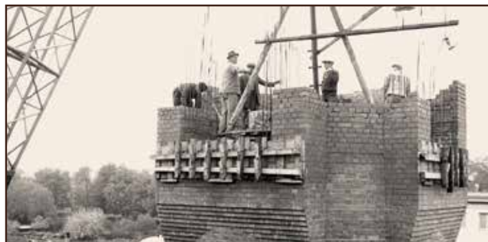
Die Bauarbeiten schreiten ohne Probleme schnell voran.
