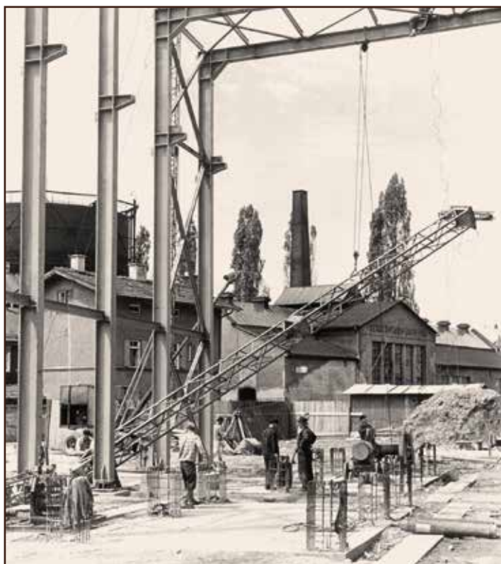
Bau des Heizkraftwerks mit Blick auf das alte Gaswerk.
