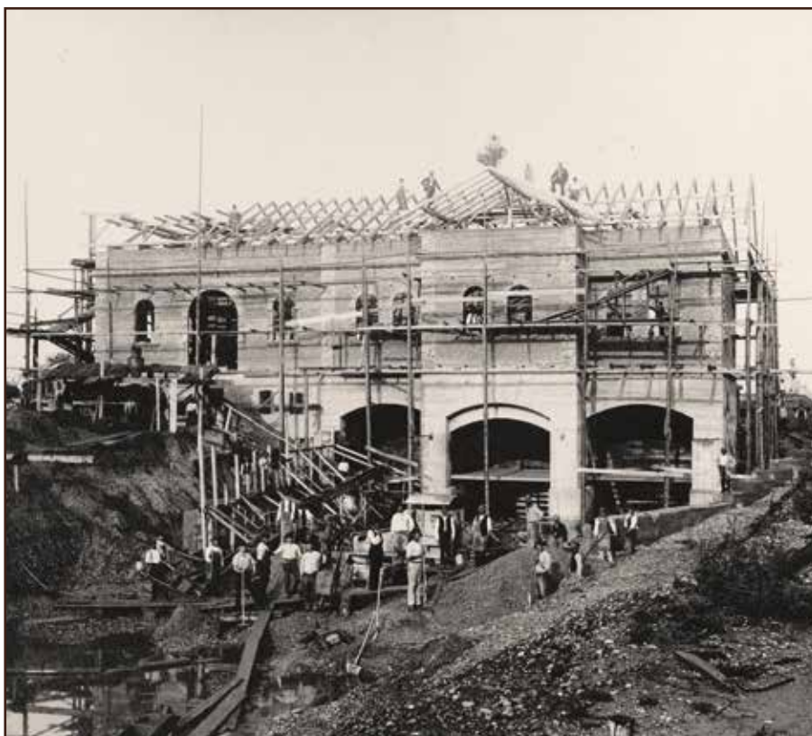
Die Arbeiten am Rohbau des kombinierten Wasser- Dampfkraftwerkes um 1895.
