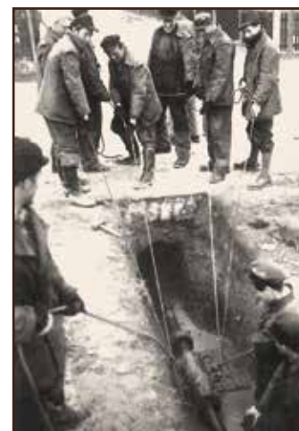
Arbeiter während der Verlegung des 20 kV-Versorgungsnetzes.
