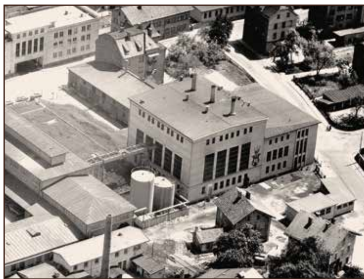
Das fertiggestellte Heizkraftwerk 1955 aus der Luftperspektive.
