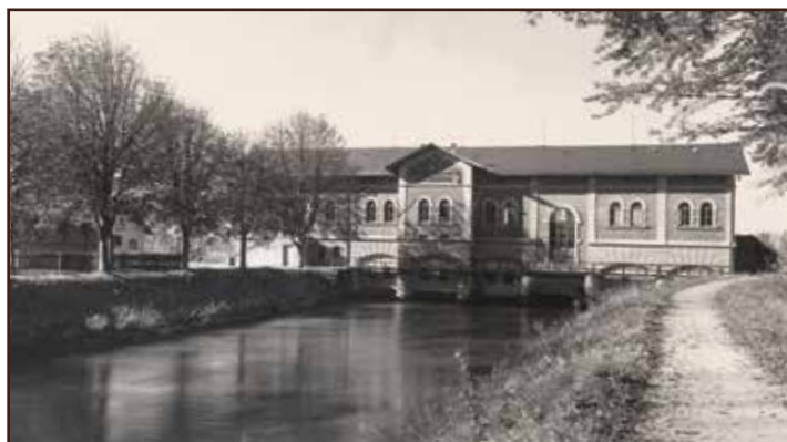
Nach dem Umbau - größer, ohne Kamin und ein reines Wasserkraftwerk.
