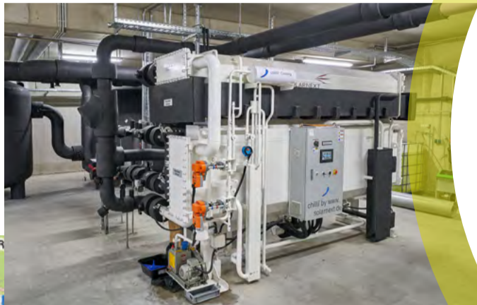
Die Absorptionskälteanlage versorgt das Quartier Bahnhof Nord mit klimaschonend erzeugter Kälte.
