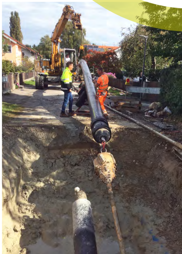
Spülen, bohren, pressen oder in offener Bauweise: Wie die Leitungen verlegt werden, entscheidet die Situation vor Ort.
