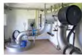
► In städtischen Brunnen schützen UV-Anlagen das Bakterien vor dem Einfließen von Grundwasser.
