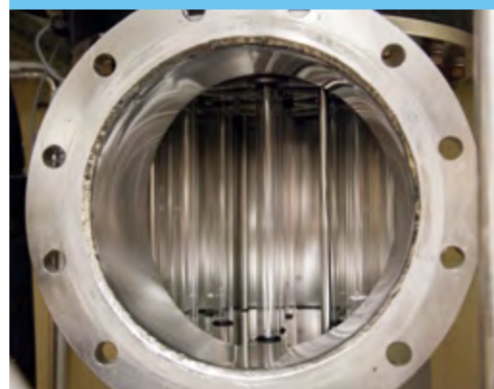
Laboranalyse von Trinkwasserproben Blick in eine UV-Desinfektions-Anlage
