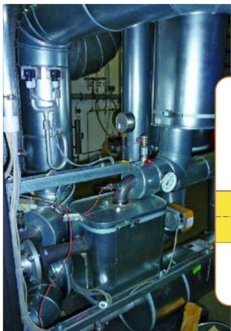
Neue Fernwärme-Übergabestation reduziert Wärmeverluste.
