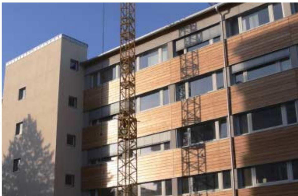
Die beiden Verwaltungsgebäude der Stadtwerke erhielten eine neue Dach- und Wärmedämmung.
