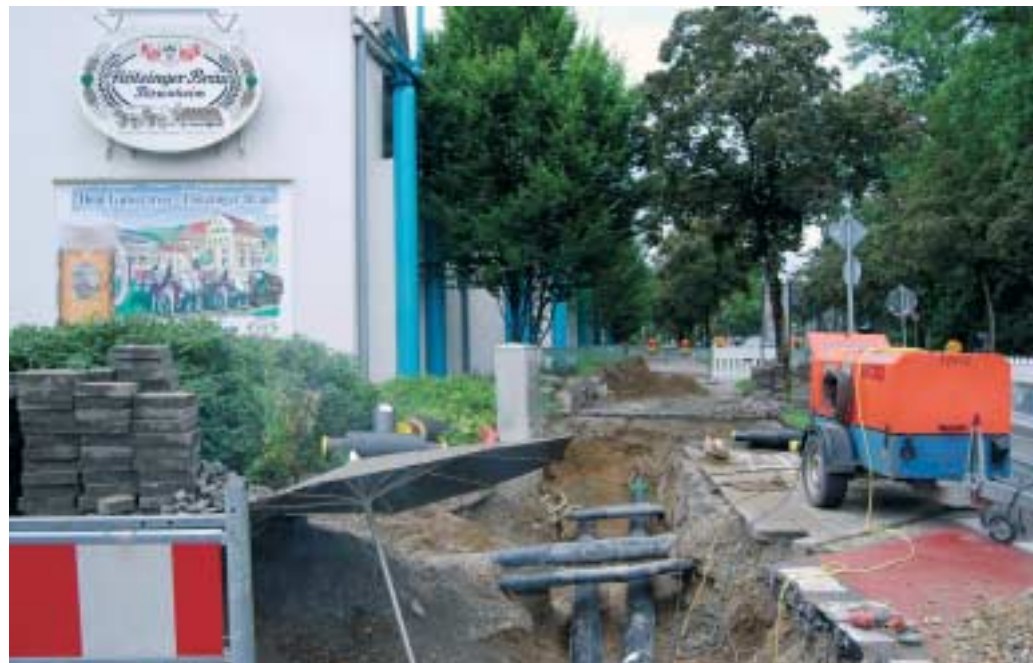
Schnellstmöglich wurde die Verlegung des Fernwärmeanschlusses in die Herzog-Heinrich-Straße 7 zur Flötzingener Brauerei durchgeführt.
