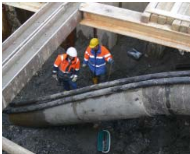
Ein externer Sicherheitskoordinator überwachte täglich die äußerst anspruchsvolle Baustelle der Stadtwerke direkt an der Uferböschung des Inns. Die vier Meter tiefe Baugrube musste vor der Aushebung mit Spundwänden gestützt werden.
