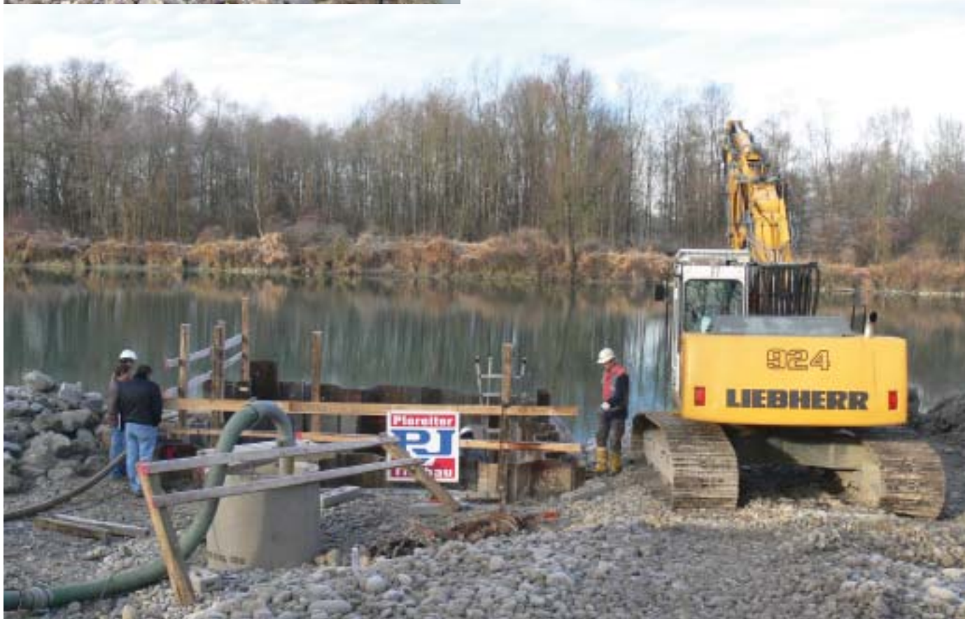
Ein externer Sicherheitskoordinator überwachte täglich die äußerst anspruchsvolle Baustelle der Stadtwerke direkt an der Uferböschung des Inns. Die vier Meter tiefe Baugrube musste vor der Aushebung mit Spundwänden gestützt werden.
