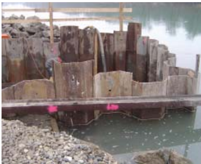
Ein externer Sicherheitskoordinator überwachte täglich die äußerst anspruchsvolle Baustelle der Stadtwerke direkt an der Uferböschung des Inns. Die vier Meter tiefe Baugrube musste vor der Aushebung mit Spundwänden gestützt werden.
