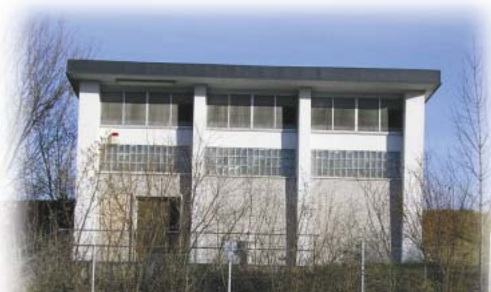
Hochbehälter von außen ...
