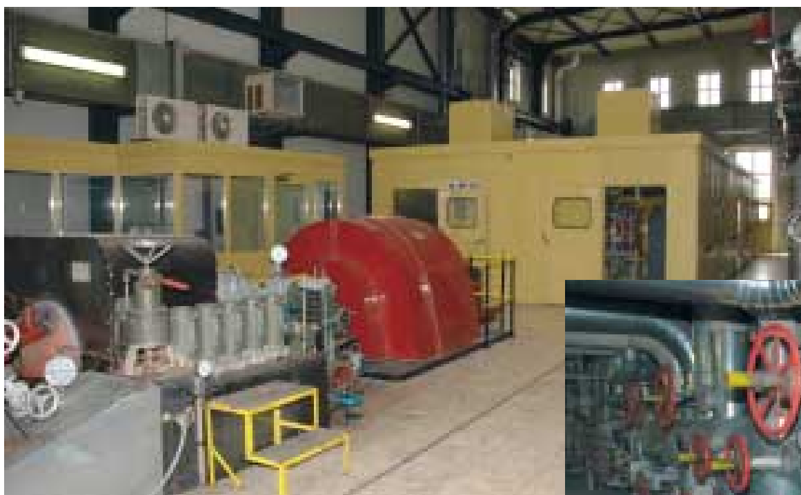
Sauber, sauber: die Turbinenhalle
